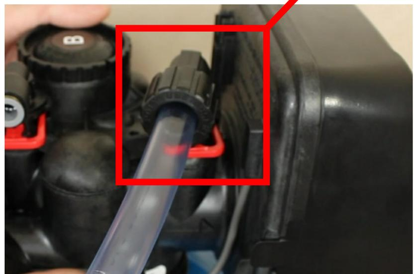
*Wir weisen darauf hin, dass bei den Modellen 18 x 65 und 21 x 62 der Abwasseranschluss in 1 Zoll geliefert wird.*
