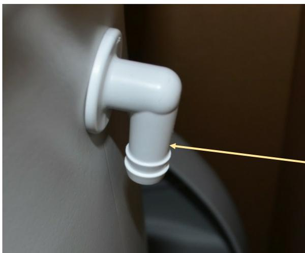
Der Anschluss für den Überlaufschlauch befindet sich am Salzlösebehälter, hier einfach den Überlaufschlauch 1/2" aufschieben.
